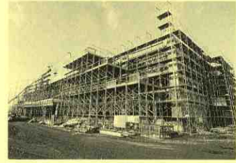
新校舎工事本着工
